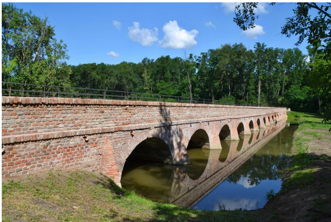
Obr. P1.30: Pohled na obnovený most Portz Insel, slavnostně otevřený dne 3. 7. 2020.
