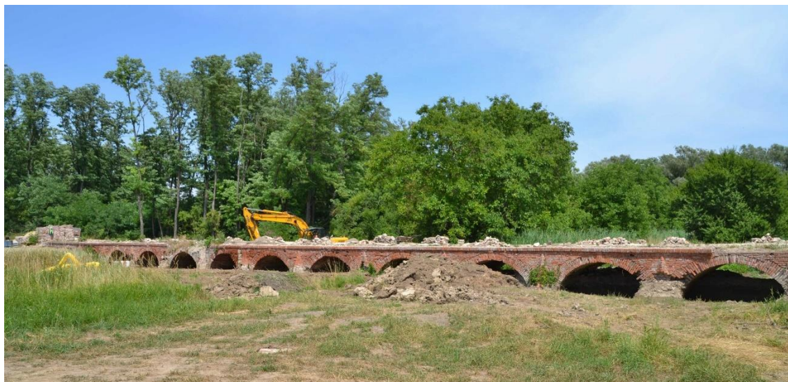
Obr. P1.3: Celkový pohled na most po odstranění nánosů bahna (1. 7. 2020).
