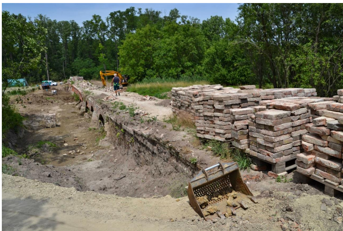
Obr. P1.4: Při odstranění nánosů bahna byly všechny nalezené cihly pečlivě vytříděny, očištěny a naskládány na palety. Přesto se ukázalo, že na obnovu mostu nebudou stačit. (foto dne 1. 7. 2020).
