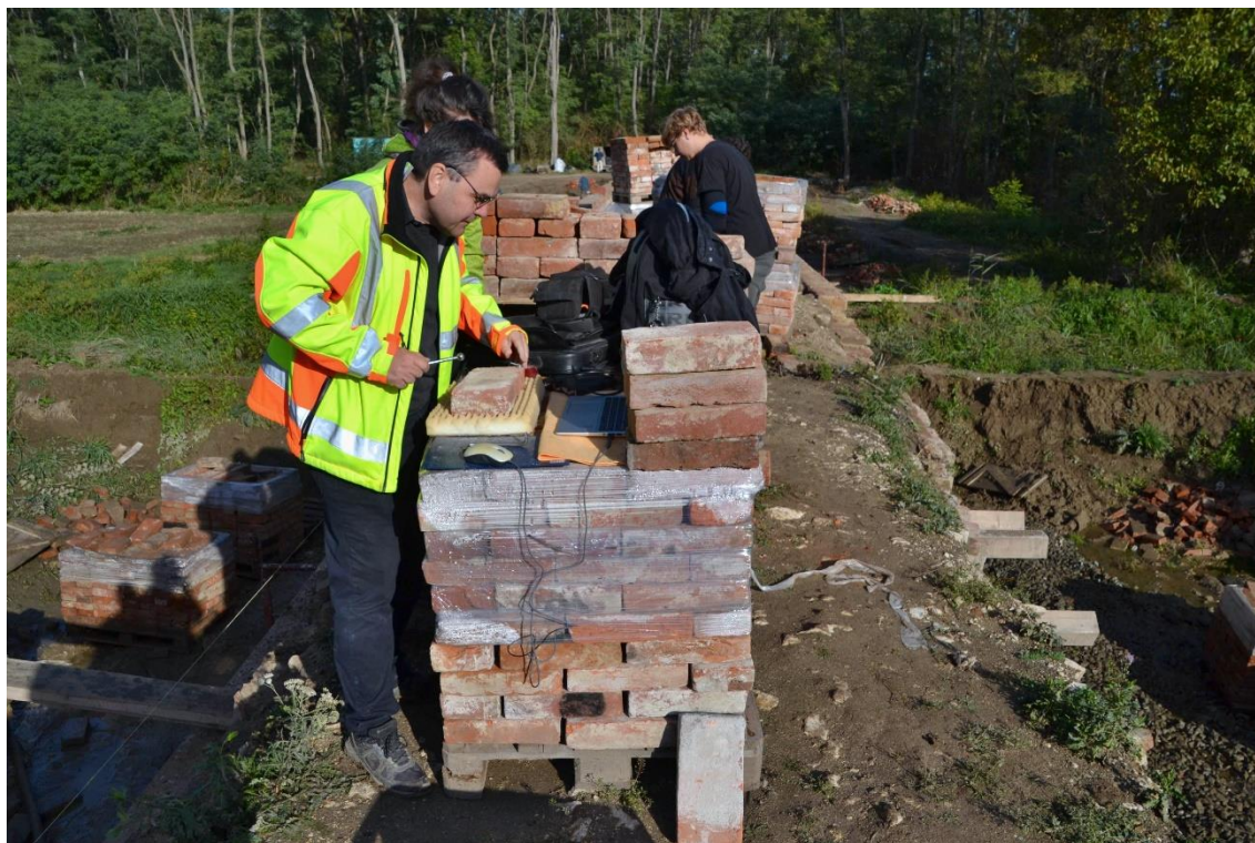
Obr. P1.29: Rezonanční zkouška prováděná in situ na cihlách, jejichž kvalita byla vizuálně a jednoduchými metodami stanovena jako diskutabilní.
